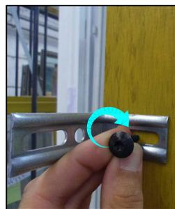
Placer la vis de 30 au milieu du trou oblong (pour garder une possibilité de réglage) puis visser avec un embout *Torx*.
